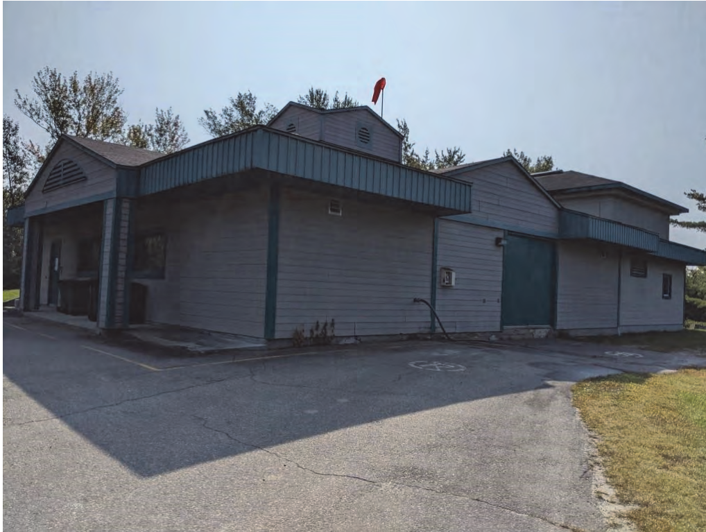
Photo 3 : Aperçu du bâtiment de production d'eau potable de la rivière du Diable– 2020-09-21
