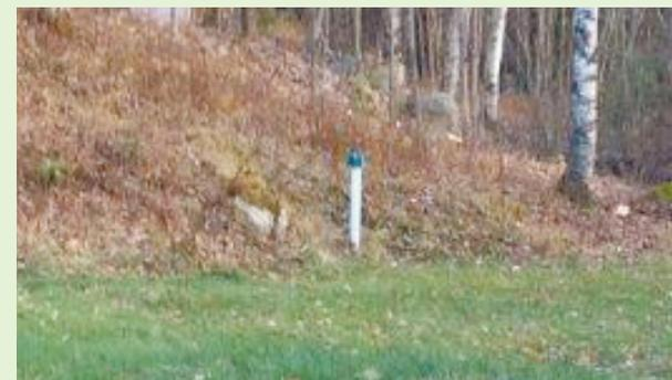
Pour l'Enviro-septic, les tuyaux servant à l'aération (évent) et comme piézomètre, le dispositif d'échantillonnage et la boîte de distribution sont visibles une fois le terrain aménagé (sur cette photo, seul l'évent est visible).
