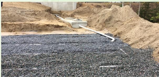
Fosse septique (réservoir en béton) suivie d'un champ d'épuration (un type d'élément épurateur).
