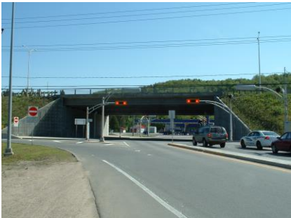
Porte d'entrée route 117 / montée Ryan : requiert une amélioration de l'image, par la mise en place d'aménagements paysagers
