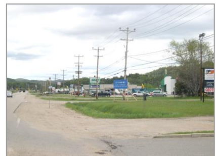
Corridor à restructurer (route 117)
