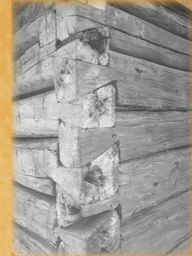
Détail d'un assemblage à queue d'aronde d'une maison pièce sur pièce, ce qui signifie « en forme de queue d'hirondelle ».
