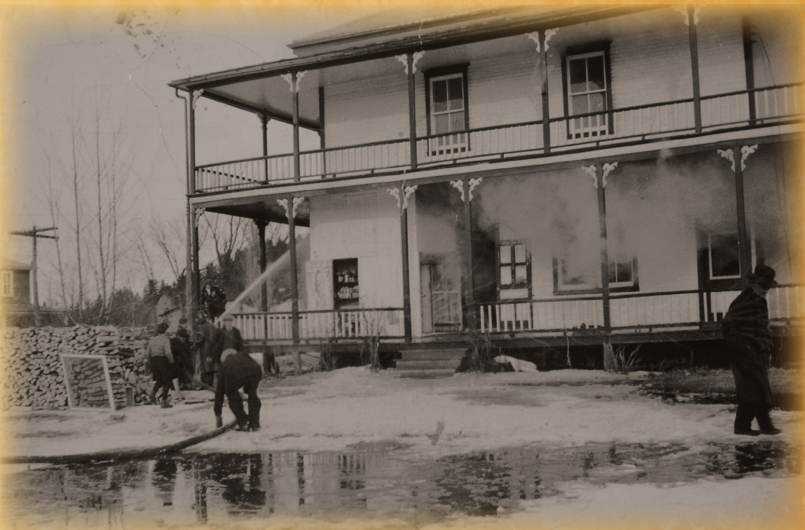
Feu de l'école des garçons et de l'hôtel de ville en 1941. Source : collection de la Société du Patrimoine SOPABIC
