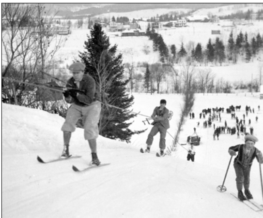
Le câble de remontée mécanique d'Alex Foster, à Shawbridge : une invention qui révolutionna la pratique du ski dans tout le continent. – Source : Archives du Canadien Pacifique.
