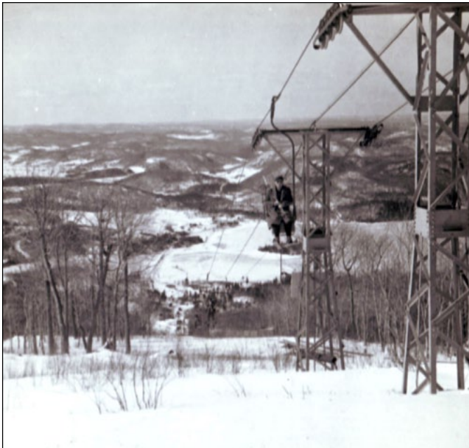
Le célèbre télésiège du mont Tremblant, qui fit pendant longtemps la renommée de la station. – Source : collection Danielle Soucy.
